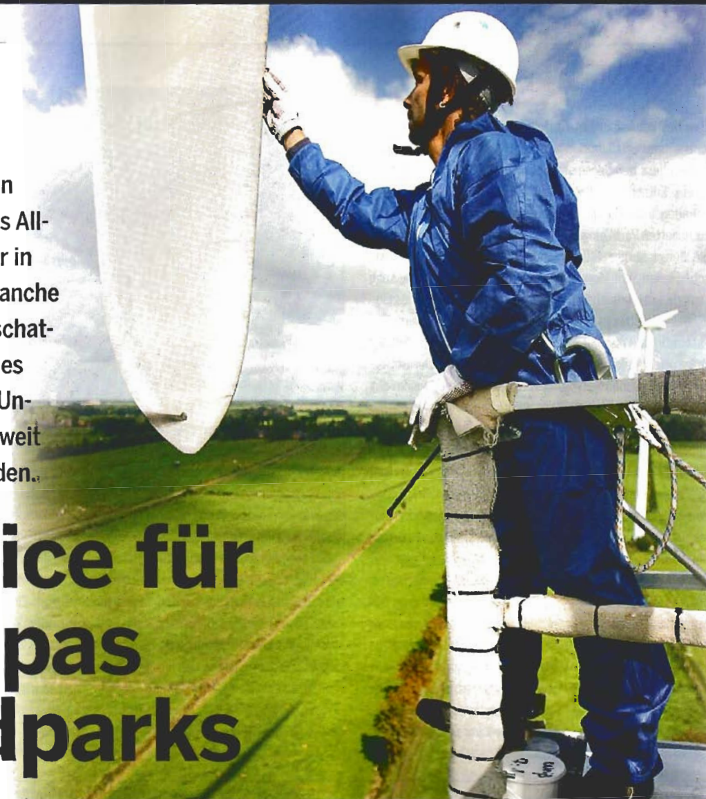
Alle Rotorblätter werden vor Ort begutachtet und gegebenenfalls repariert.
